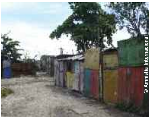
La zona urbana deprimida de Majesty Gardens, Kingston, 2 de octubre de 2007. Muchos hogares de estas comunidades carecen de infraestructura básica, como canalización de agua potable o alcantarillado
