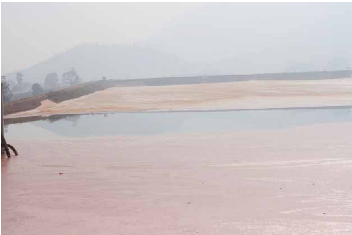
Photo 11 : Vue du bassin de boues rouges de la raffinerie de Lanjigarh (Amnesty International)
