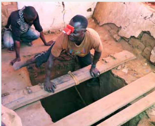
采矿者将手脚放进矿井侧壁挖出的洞中爬出矿井，其间用一根系着井口横梁的绳索作为支撑。一名采矿者说，有时候绳子断了，采矿者就掉了下去。2015年5月。© 国际特赦组织和非洲资源观察组织
